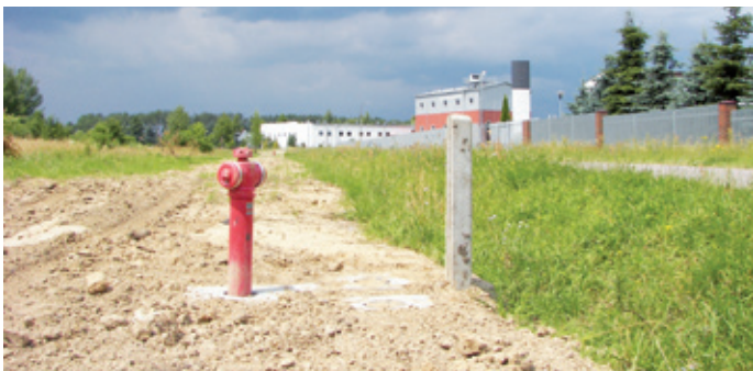
Budowa wodociągu w Ignatkach
