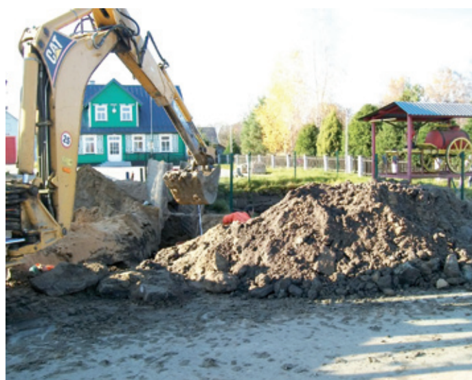
Budowa kanalizacji sanitarnej we wsi Wojszki
