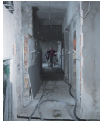
Remont bloku żywieniowego w ZS w Juchnowcu Górnym
