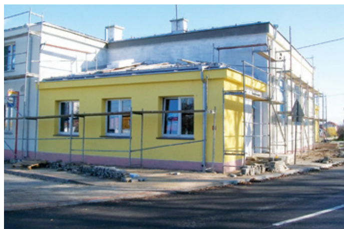
Remont i docieplenie budynku Ośrodka Kultury w Juchnowcu Kościelnym
