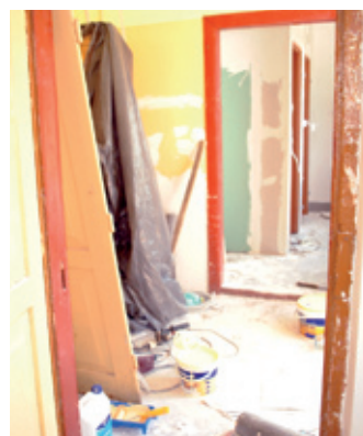
Remont świetlicy wiejskiej w Hołówkach Dużych
