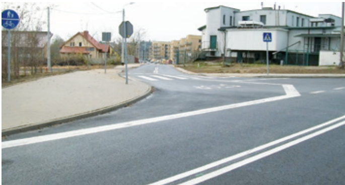
Budowa ciągu dróg w Ignatkach-Osiedlu: ulice Leśna, Przejazdowa i Jeździecka
