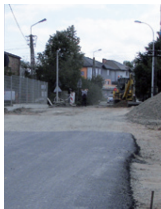
Budowa ul. Przemysłowej w Księżynie
