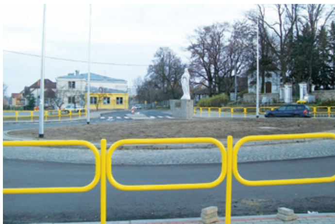
Przebudowane skrzyżowanie w Juchnowcu Kościelnym
