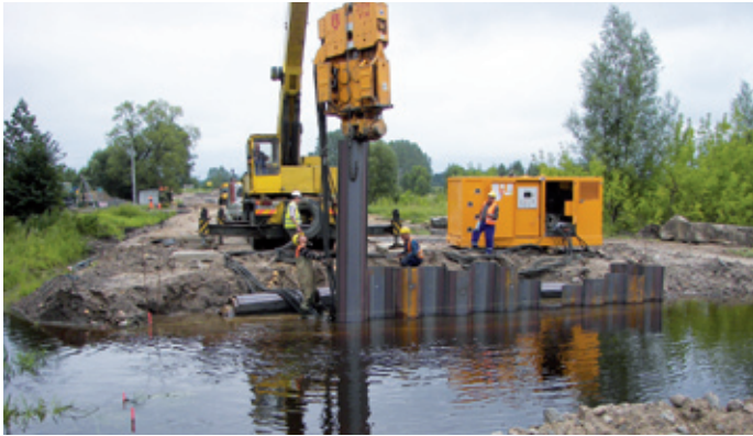
Przebudowa mostu na rzece Niewodnica w okolicy Koplany
