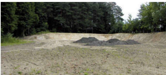
Budowa boiska w Olmontach
